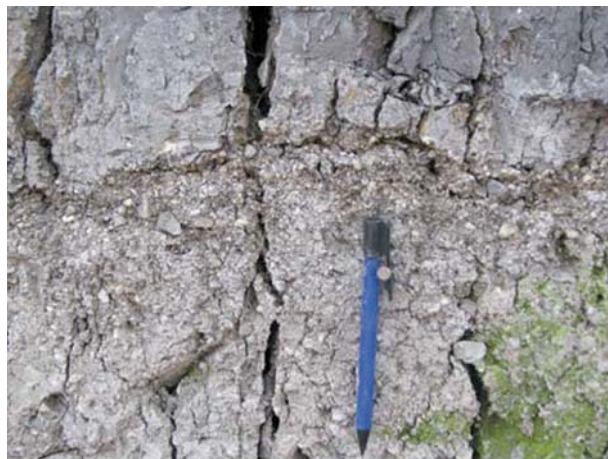
Contacto de erosión entre las turbas PB-8 (donde está el lápiz) y PB-9 (arriba), entre ambas capas una zona marcada por la presencia de un nivel de grava.
